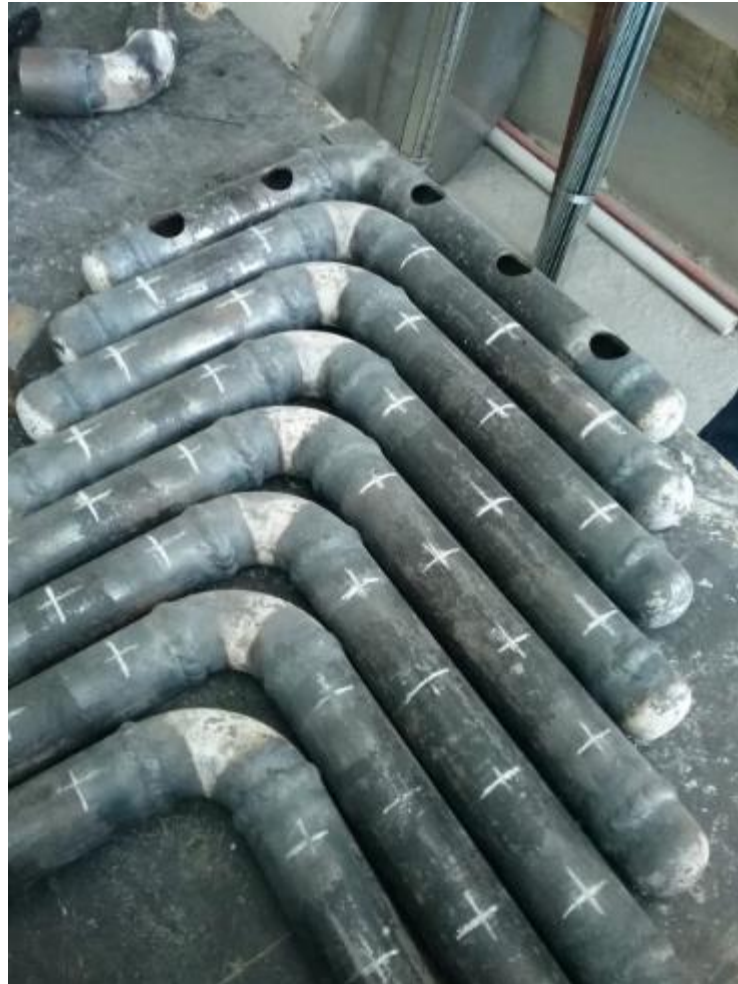
Preparación de colector con taladro de pedestal.
